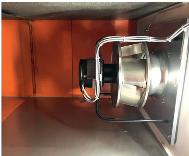
Alt versus Neu: Seit 2022 sorgen hocheffiziente EC-Ventilatoren für einen energiesparenden Betrieb der Lüftungszentrale.
