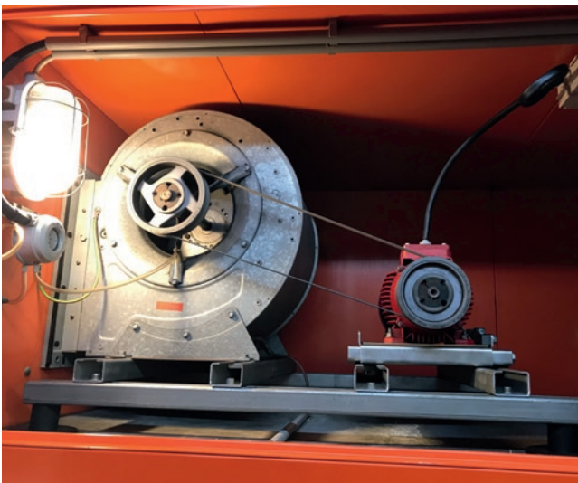
Alt versus Neu: Seit 2022 sorgen hocheffiziente EC-Ventilatoren für einen energiesparenden Betrieb der Lüftungszentrale.
